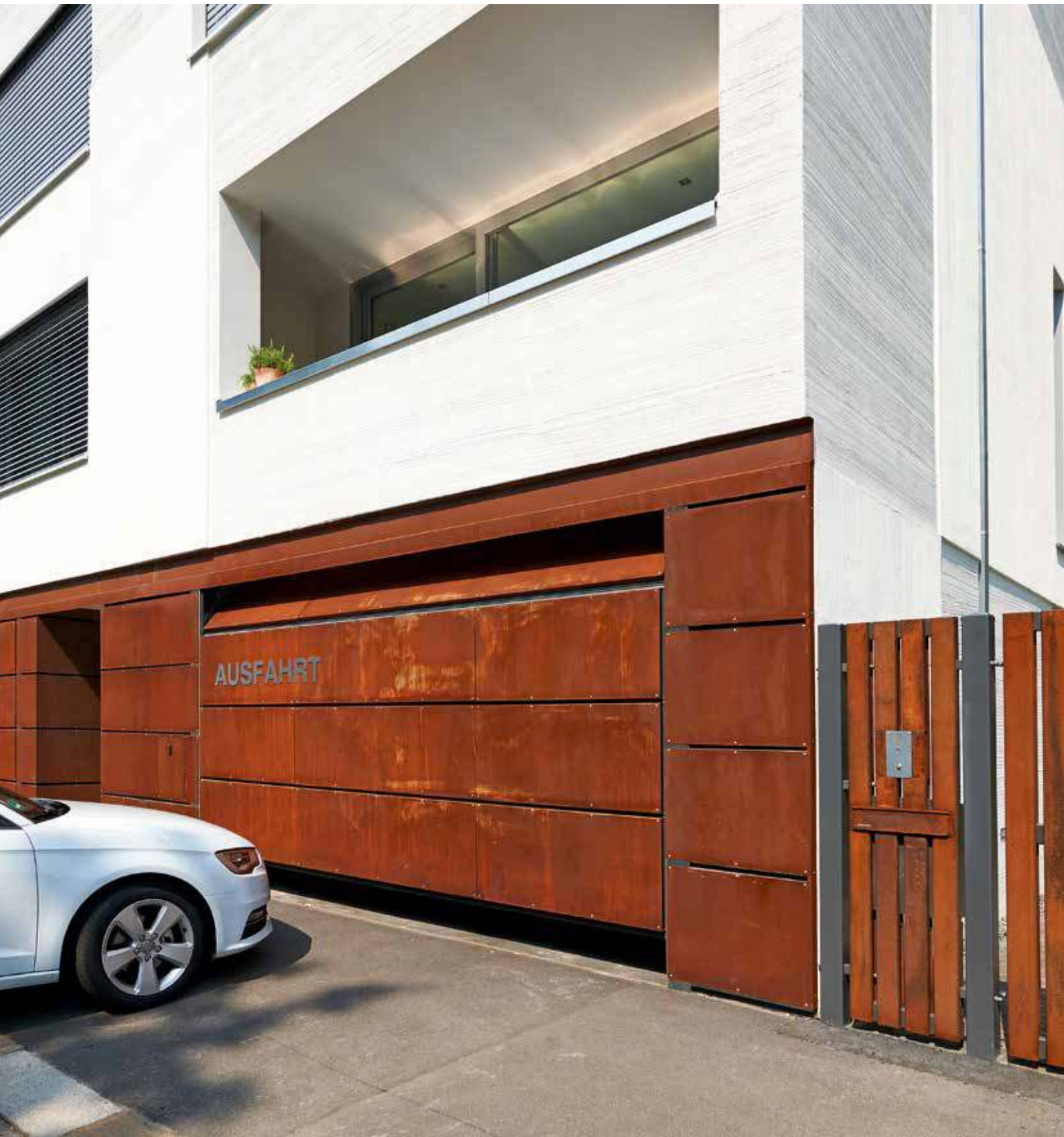
Bauseitige Beplankung mit Schichtpressplatten
