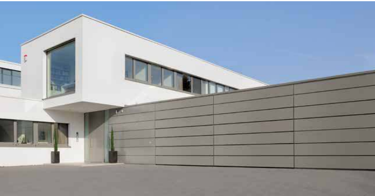
Bauseitige Beplankung mit Aluminium-Verbundplatten
